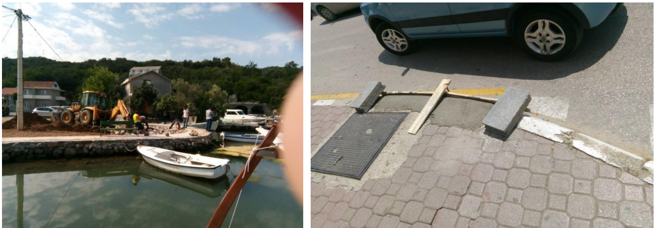
RADOVI SLUŽBE ZA ODRŽAVANJE I IZGRADNJU 2018
