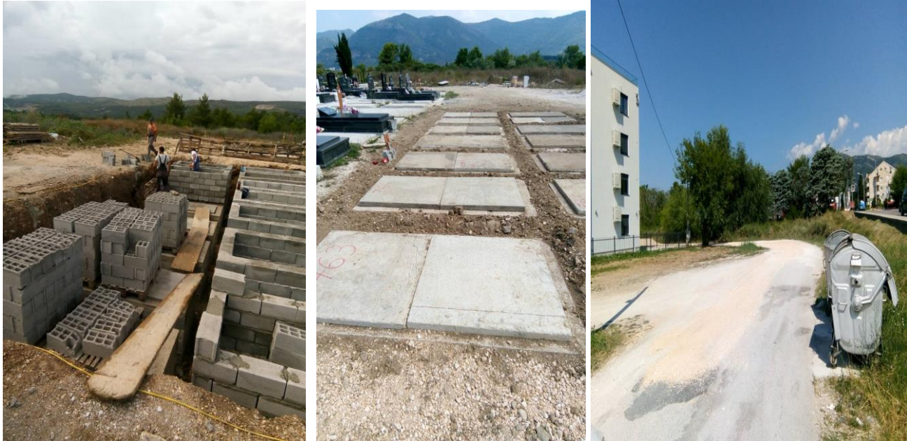
IZGRADNJA NOVIH GROBNICA »SV.SRD« 2018
